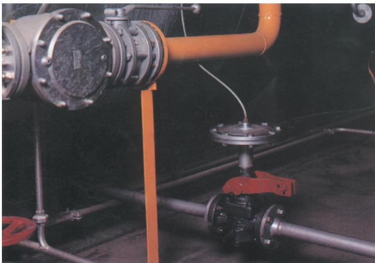
Сочетая нижний продувательный клапан для удаления грязи и осадка с поверхностным сплошным продувательным клапаном, это очень важно для улучшения эффективности котла. В то же время можно повысить в максимальной степени безопасность и коэффициент использования котла.
